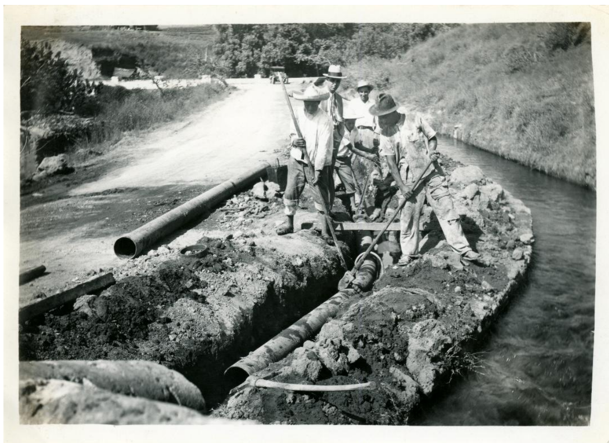
Ilustración 2 Imagen de instalación de tubería de fierro fundido en el municipio de Cuernavaca. Dr. Miguel Ángel Cuevas.
