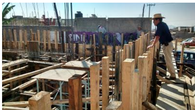
Ilustración 6 Fotografía propia de Construcción de tanque superficial "El Universo" año 2014
