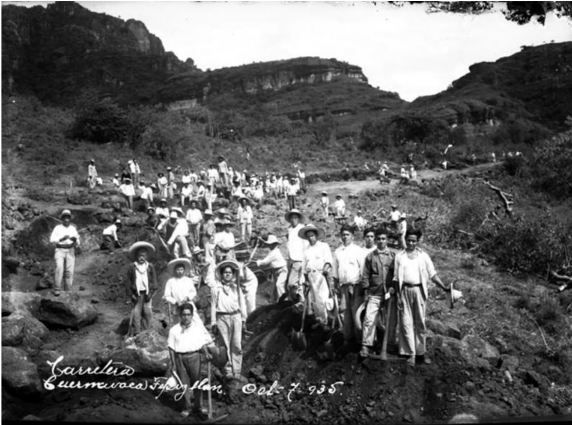
Fotografía 3. Hombres durante los trabajos de construcción de la "Carretera Cuernavaca Tepoztlán".
