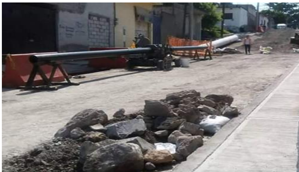
Ilustración 10. Instalación del acueducto sobre la calle Niño perdido. Apatlaco. 2016. Fotografía: Balbina Vides.
