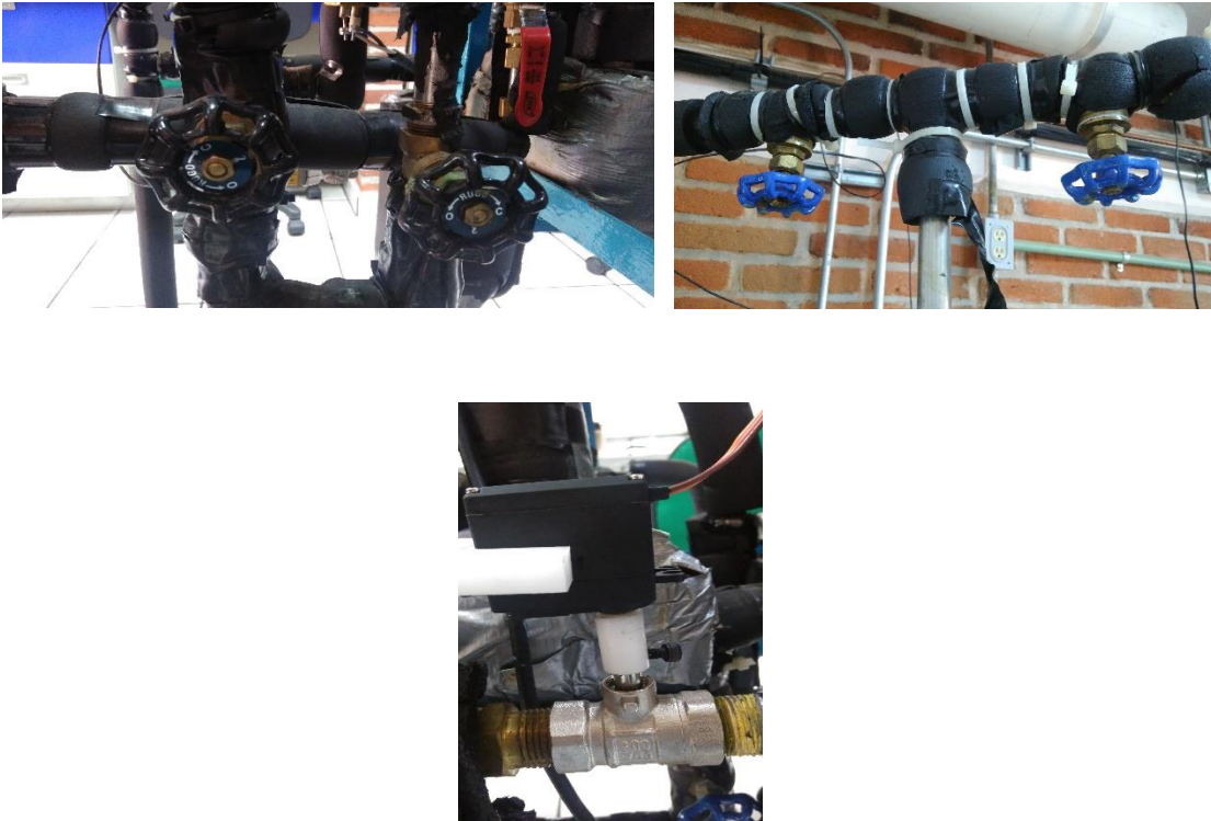
Figura 4.5.- Reemplazo de válvulas
