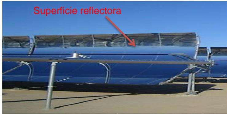
**Figura 3.1 :** Superficie reflectora de un CCP, figura modificada (2017)
