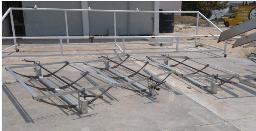
c) Vista real de la estructura básica de los colectores
