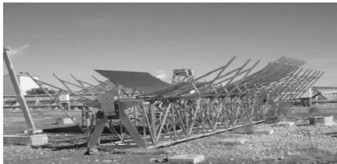
**Figura 2.10 :** Estructura de soporte del Eurotrough. (Esteban y al, 2001)
