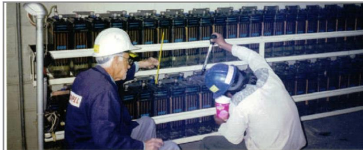
Figura 2.6 Revisión de los electrolitos en el banco de baterías [24].
