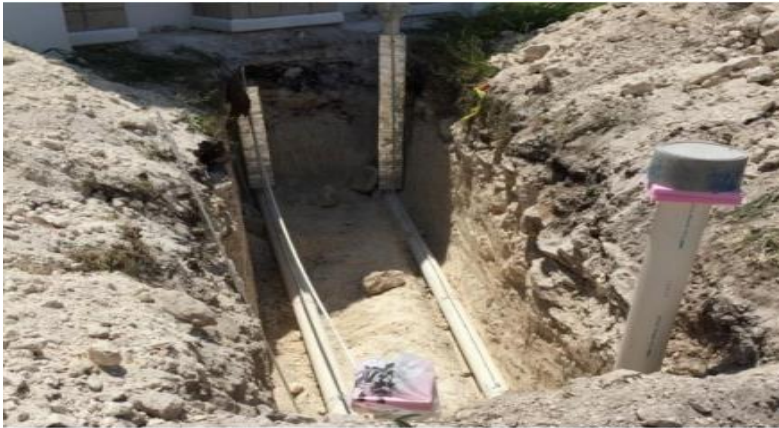
Figura 4.21. Detalle de construcción de los ICTA en Villas universitarias Chetumal Quintana Roo y dimensiones de construcción [88].
