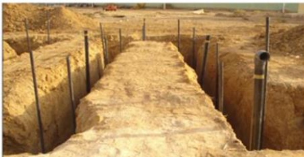
Figura 4.27. Detalle del ICTA experimental ubicado en la universidad de Biskra, Argelia, datos y dimensiones reportados por los autores [89].
