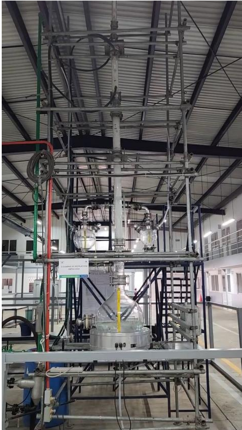
Figura 6.4. Columna de destilación empacada utilizada para la tesis.
