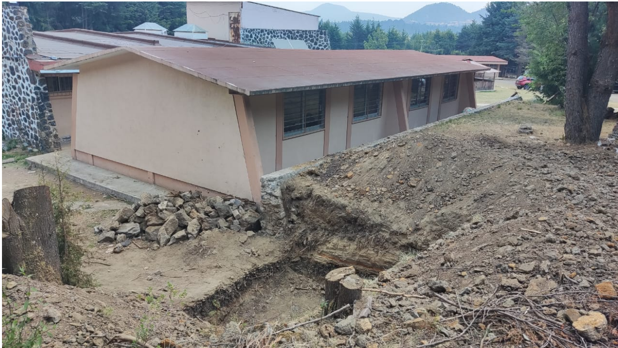
Figura 3.7 (a) Zanja realizada en el caso de estudio
