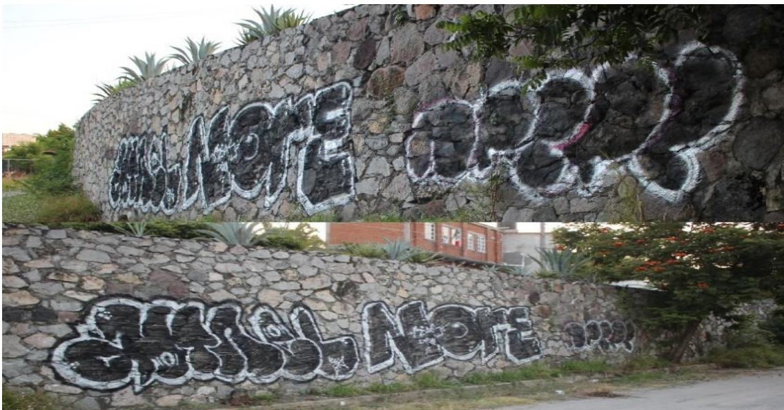
Fotografía núm. 32 “Resultado final” (autoría propia) fotografía tomada en el año 2020, ubicada en Jojutla, Morelos.
