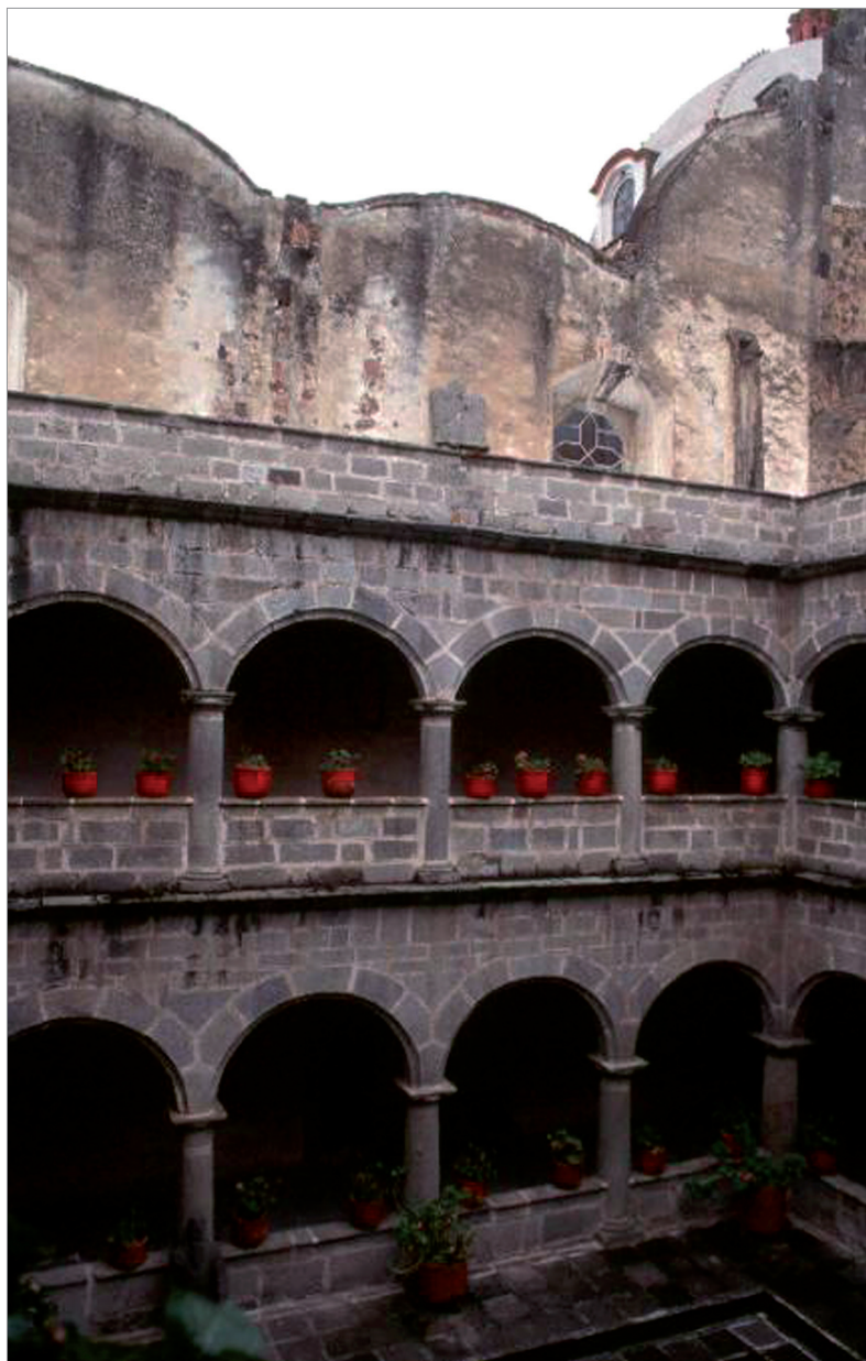
Figura 7: Convento de Zinacantepec, estado de México.
