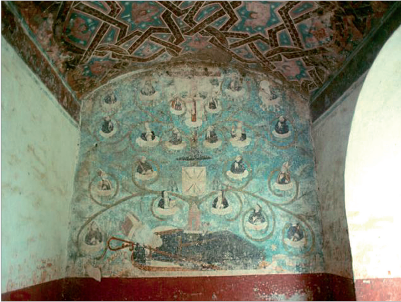
Figura 17: Portal del convento de Atlatlahucan, Morelos.
