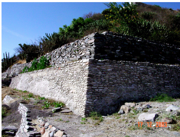
Fig. 78. Esquina sureste del basamento donde se puede apreciar el muro tolteca
