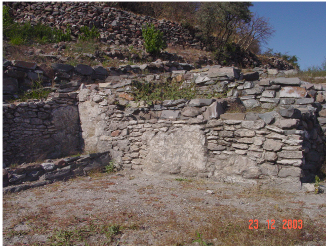
Fig. 83. Muro perteneciente a la etapa tolteca
