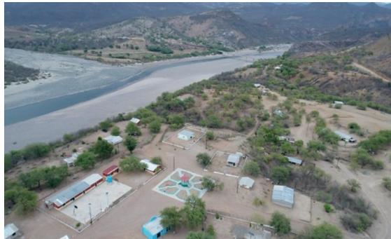
FIGURA 6. TOMA AÉREA DE LA COMUNIDAD DE TUBARES, URIQUE
