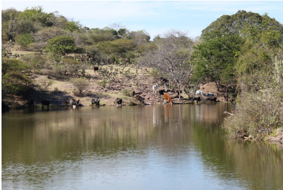
Figura 138. Vista de la presa de la comunidad de Pitzotlán
