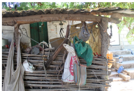
Figura 53. Tejado con horcones de madera como base
