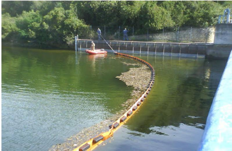
**Figura 16.** Barrera de contención antiturbidez en uso. (Imagen recuperada del sitio web Sorbcontrol).
