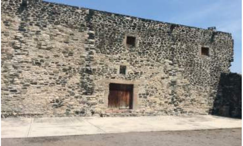
Figura 4. Fachada del convento y claustro.
