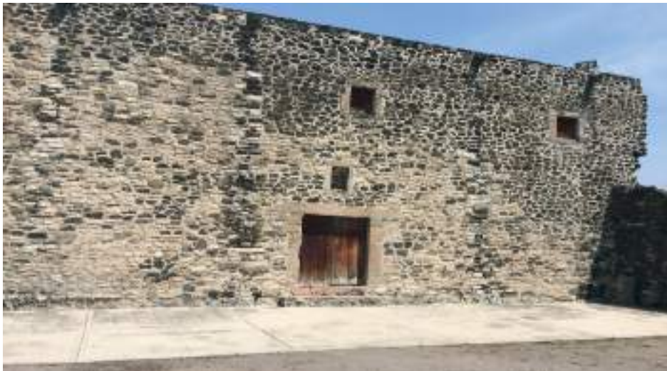
Figura 10. Muros 3 y 4 del claustro. Se relacionan en el plano en color azul.
