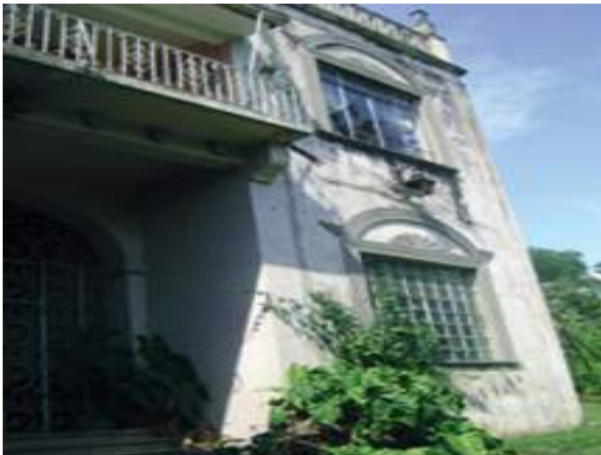
Figura 2. Detalle de fachada posterior. Fotografía tomada por la autora.
