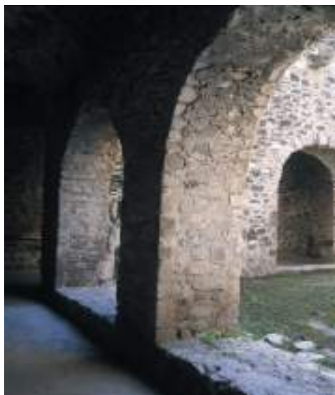
Figuras 12, 13 y 14. Arcadas del claustro bajo y alto.
