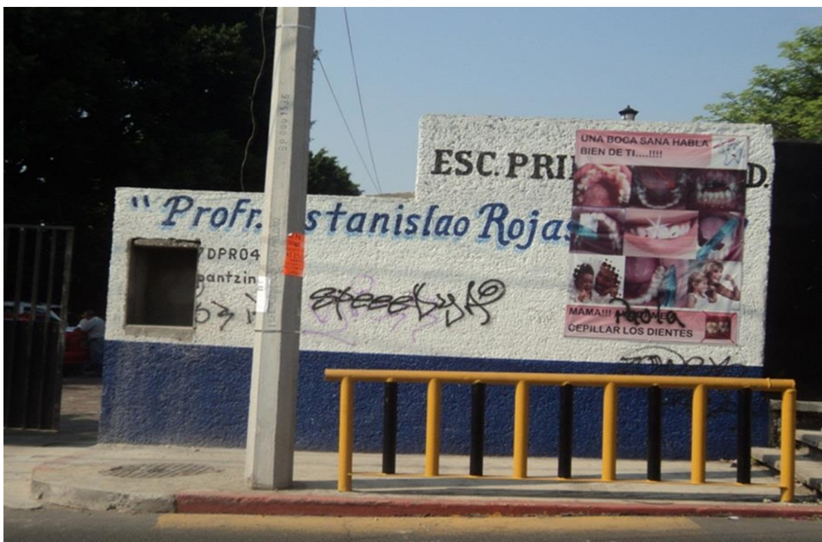
Fotografía 4. Se muestra una fachada exterior de la Escuela Primaria Federal “Prof. Estanislao Rojas Zúñiga”. Archivo Personal.
