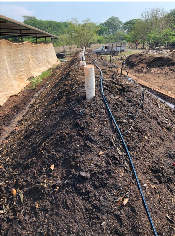
Fotografía 16: Incorporación de tubos perforados para oxigenar lombricompostas,
