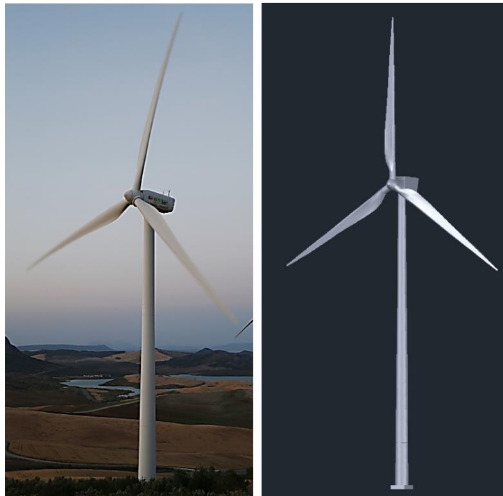
Figura 3. 6 Modelo real y numérico (GAMESA, G 87- 2 MW, 2008) .
