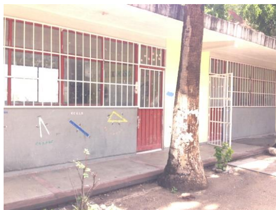
Imagen 7. Primaria, instalaciones del Albergue Emiliano Zapata
