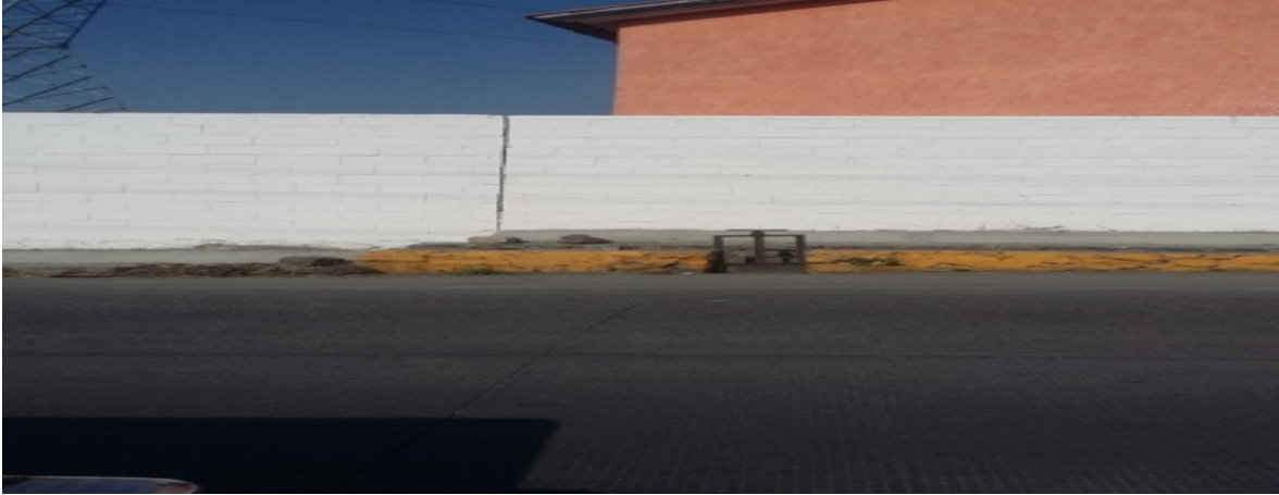
Fotografía 2. Compuerta reguladora de agua en el ejido de Acatlipa . Temixco, 2 de abril de 2019 Foto: Maritza Cantu.
