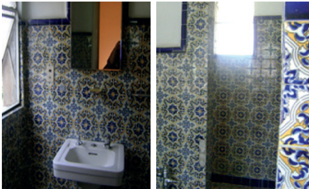
Figura 8. Baño de la recámara principal en acabado de mosaico tipo talavera. En la fotografía se muestra un lavabo que seguramente no es el original. Fotografías tomadas por la autora.
