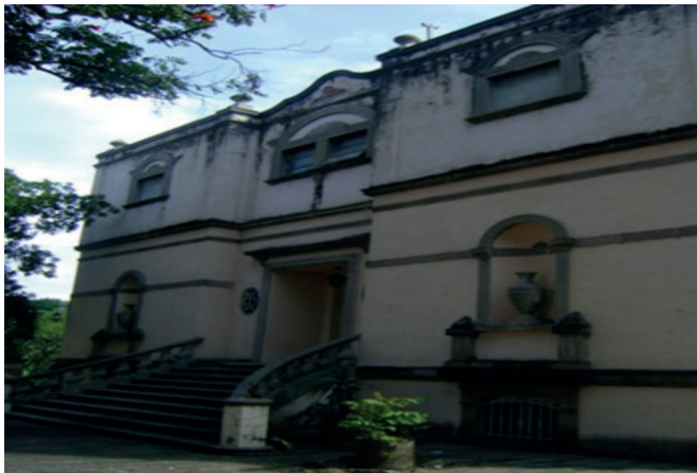
Ejemplo 9. Fachada principal de la casa con escalinata de acceso. Fotografía tomada por la autora.
