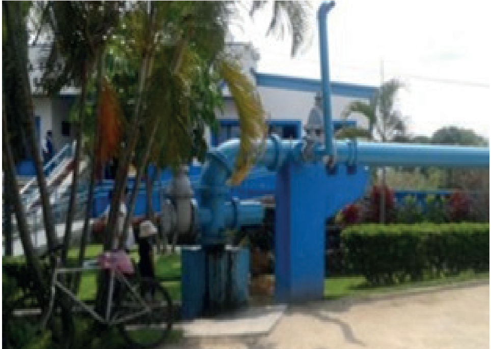
Figura 1. Acceso a las instalaciones del Sistema Operador de Agua Potable y Alcantarillado de Cuautla, Morelos.
