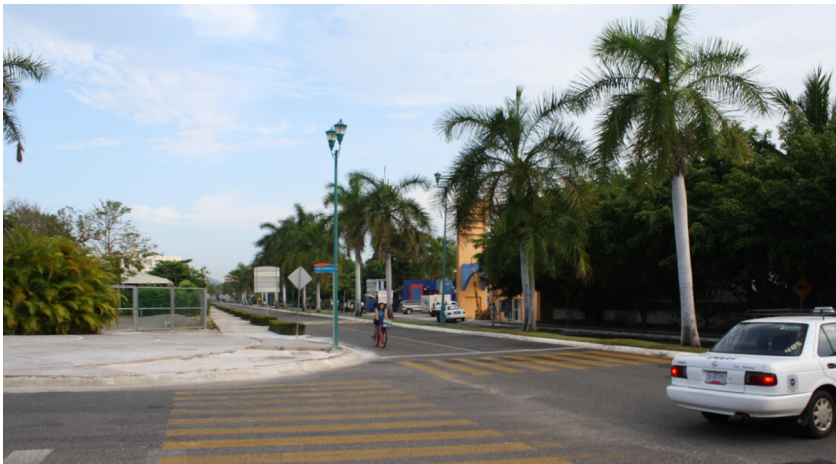
Figura 2. En el CIP de Ixtapa-Zihuatanejo la infraestructura es subterránea
