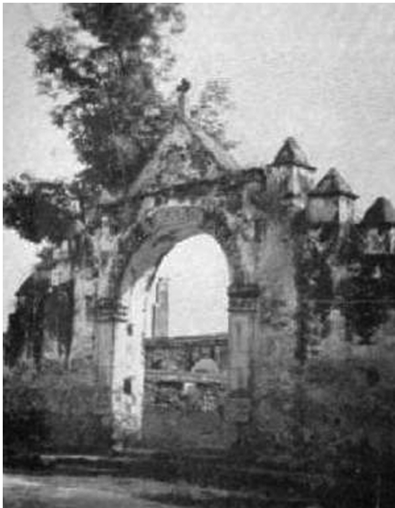
Fig. 12. Portón del convento de Xochitepec (Robles, 1934: 49).
