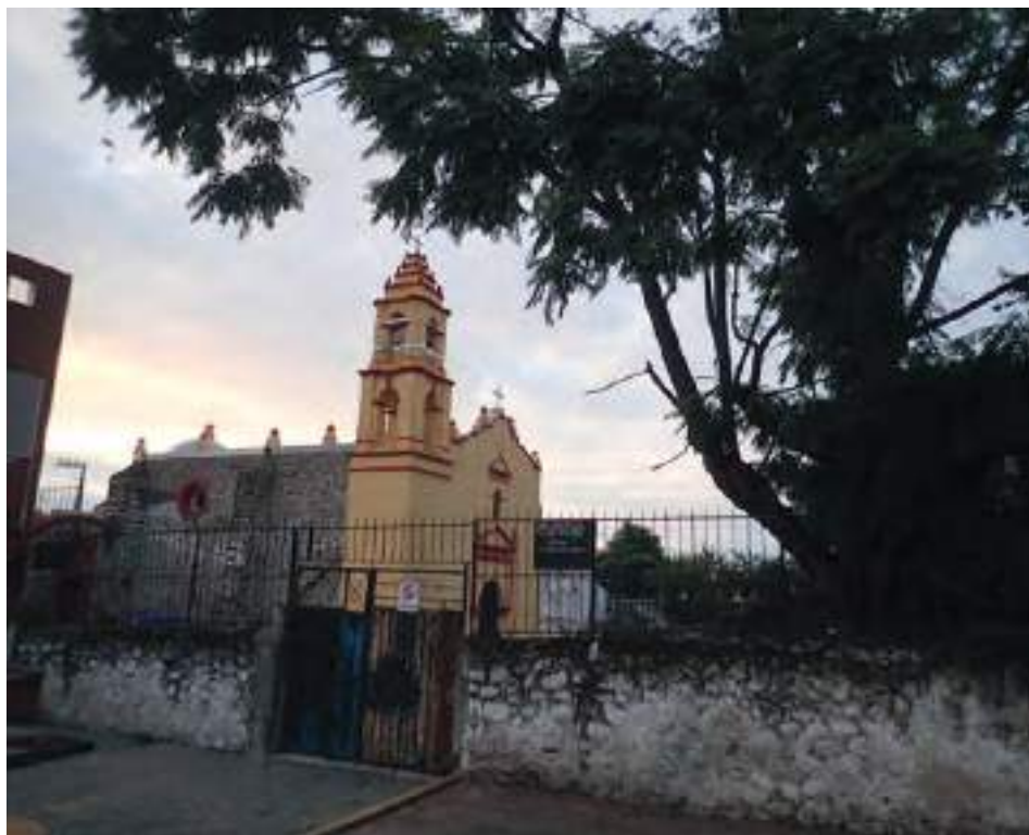
Figura 19. Fachada lateral de la iglesia de Cuentepec. Foto: Santana, 2019.
