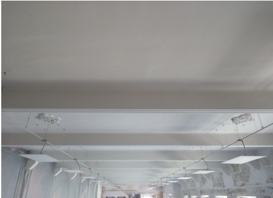
Fig. 35. Travesaños en el techo de la biblioteca.
