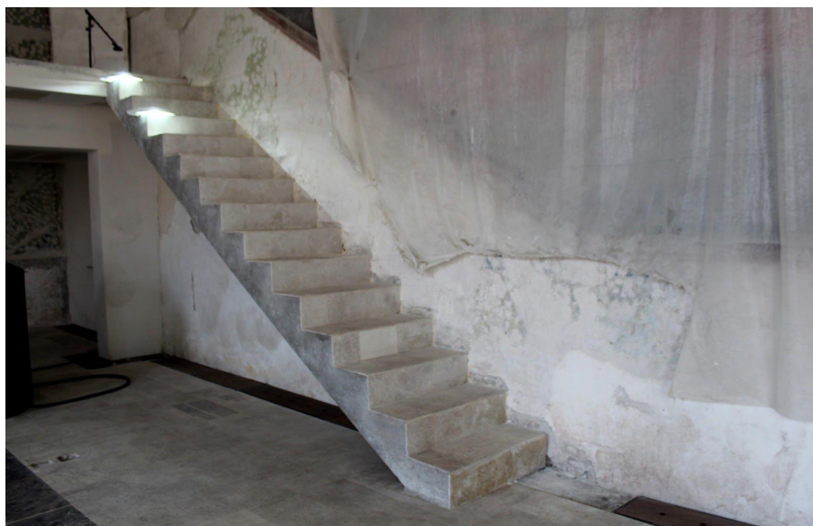
Fig. 37. Escalera con reflectores para generar sombras de los peldaños
