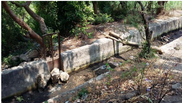
Foto 42. Deterioro en compuertas del canal principal margen izquierdo de la Toma 5, Yautepec. 2017. Autor: René Gadea N.
