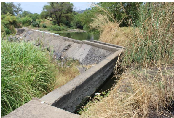
Foto 58. Presa, bocatoma y canal principal de la Toma 6, Yautepec. 2017. Autor: René Gadea N.
