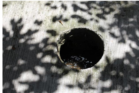
Foto 67. En algunos puentes se dejan aberturas para poder sacar agua con cubetas, Oacalco. 2016. Autor: René Gadea N.
