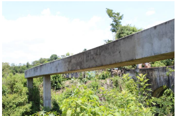
Foto 29. Daño por sismo en el puente canal, con riesgo de colapsar, Oaxtepec. 2018. Autor: Anqélica Alemán O.
