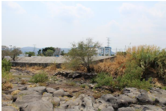
Foto 65. Condiciones del río Yautepec a la altura de las Tomas 6 y 7 en el mes de mayo, Yautepec. 2017. Autor: René Gadea N.
