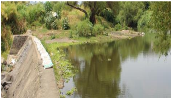
Foto 62. Uso de costales con arena en presa, Toma 6, Yautepec. 2017. Autor: René Gadea N.
