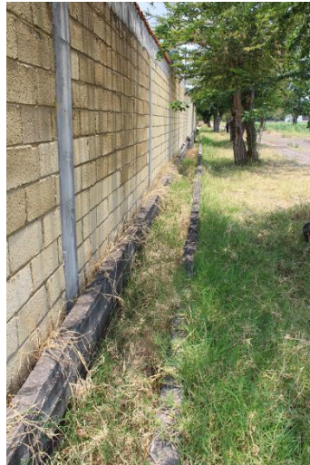
Fotos 56 y 57. Falta de mantenimiento de canales, Toma 6, Col. Diego Ruíz. 2017. Autor: René Gadea N.
