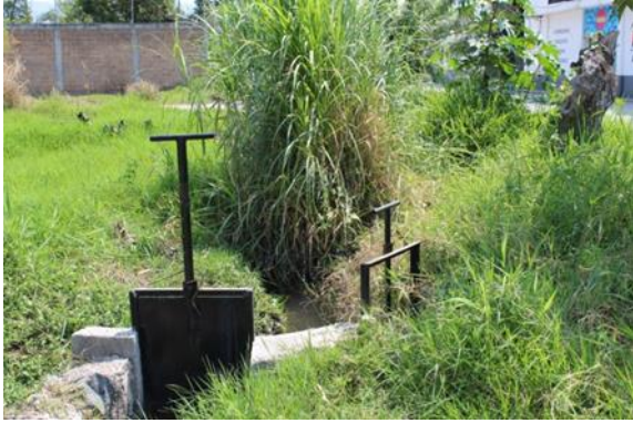
Foto 22. Compuertas en Campo el Marqués, Yautepec. 2016. Autor: René Gadea N.
