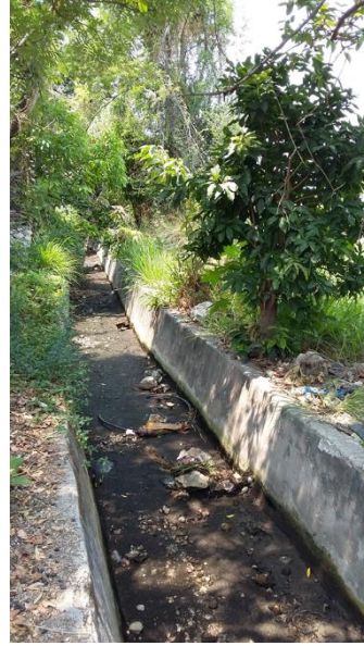
Foto 41. Enzolve en el canal principal del margen izquierdo de la Toma 5, Yautepec. 2017. Autor: René Gadea N.
