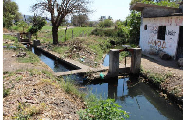
Foto 35. Canal principal y secundario de la Toma 4, Yautepec. 2018. Autor: René Gadea N.
