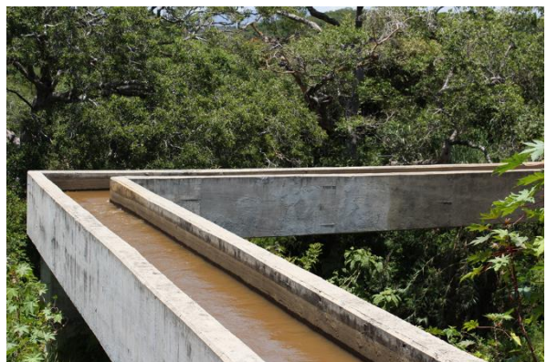
Foto 33. Conducción de agua en el puente canal dañado, Oaxtepec. 2018. Autor: Angélica Alemán O.
