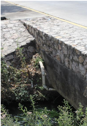
Foto 66. Instalación de tuberías para extraer agua a través de bombas de los canales de riego, Yautepec. 2016. Autor: René Gadea N.
