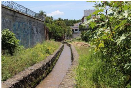
Foto 60. Canal revestido con piedra y cemento, Toma 2, Oaxtepec. 2018. Autor: Angélica Alemán O.
