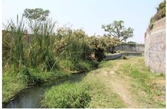
Foto 16. Canal principal del manantial El Michate, Oacalco. 2016. Autor: René Gadea N.
