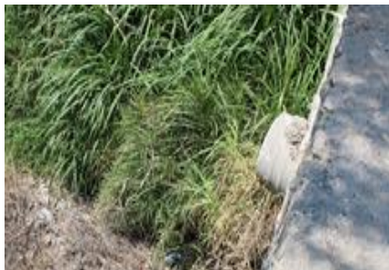
Foto 12. Drenajes sobre los canales de riego, Oacalco. 2016. Autor: René Gadea N.
