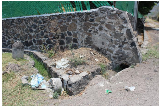
Foto 51. Abandono de infraestructura hidráulica por inequidad del recurso en la Toma 6, Col. Diego Ruíz. 2017. Autor: René Gadea N.
