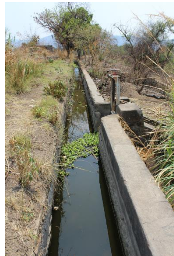
Foto 59. Canal principal y compuerta de desfogue de la Toma 6, Yautepec. 2017. Autor: René Gadea N.
