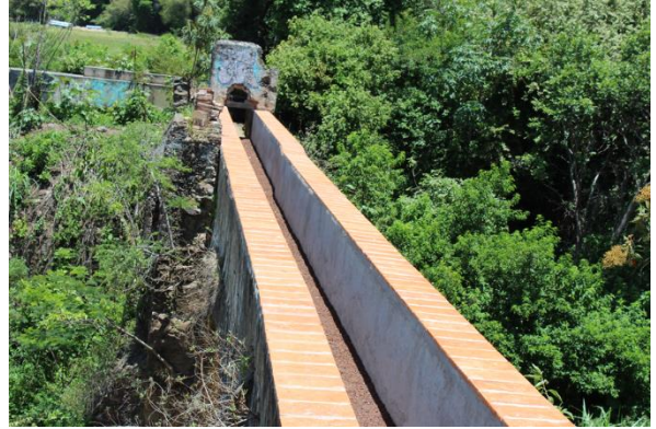
Foto 31. Rehabilitación del puente canal antiguo, de la época de las haciendas, Oaxtepec. 2018. Autor: Anqélica Alemán O.
