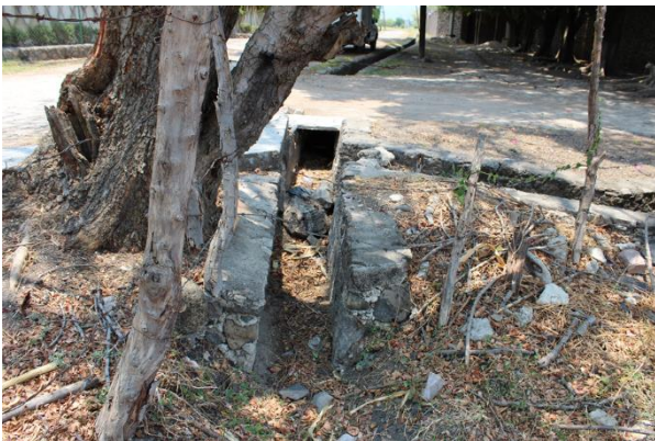
Foto 52. Deterioro de infraestructura hidráulica en la Toma 6, Col. Diego Ruíz. 2017. Autor: René Gadea N.1
