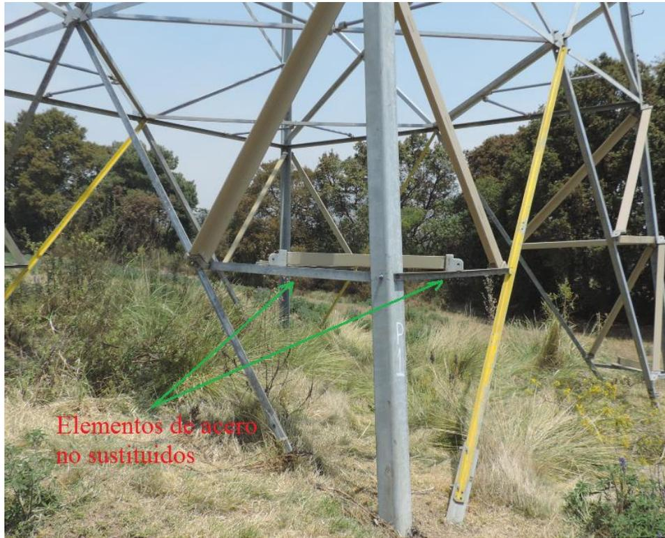
Figura 5.6–1. Elementos redundantes de acero no sustituidos en las torres.
