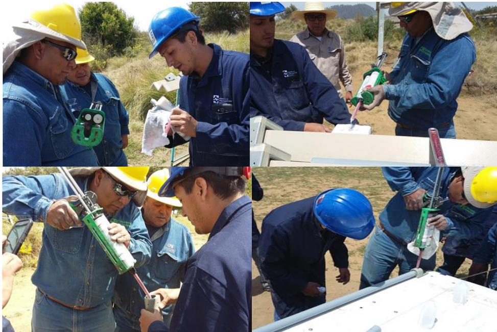
*Figura 5.4.3–1. Aplicación del adhesivo.*
