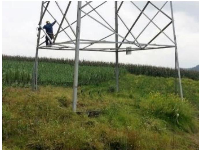
*Figura 2.3–2. Elementos sustraídos del bottom panel.*
