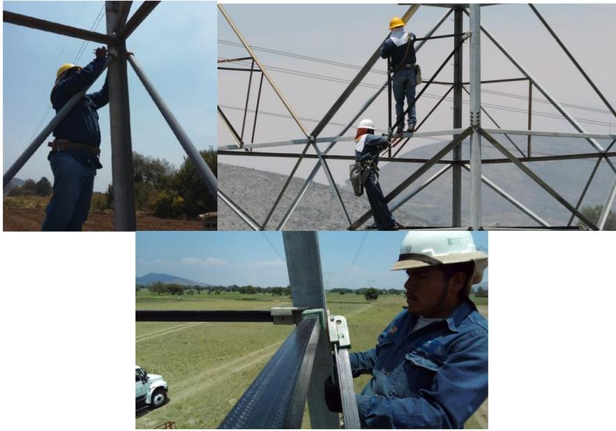
Figura 5.5–1. Instalación de los perfiles en la torre.
