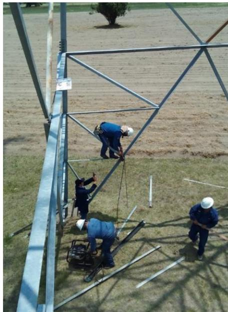
*Figura 5.3–2. Retiro de los elementos redundantes de acero de la torre.*
