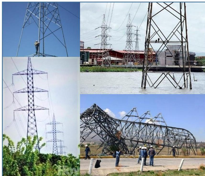
*Figura 2.3–3. Torres con elementos sustraídos (de izquierda a derecha [23][19][18][26]).*
