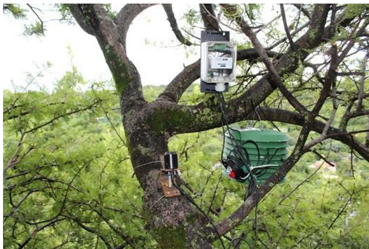
Figura 7. Instalación de unidades de monitoreo ambiental (Foto: Luis Sánchez).
