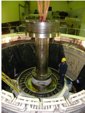
Figuras 5.35. y 5.36. Montaje eje de generador.
