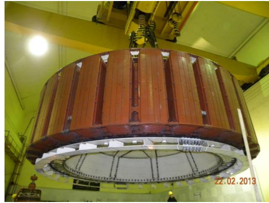
Figuras 5.41. y 5.42. Estator y rotor de generador.
