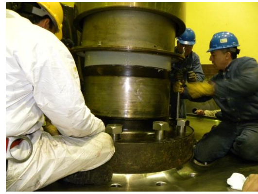
Figuras 5.19. y 5.20. Acoplamiento rodete con eje de turbina.
