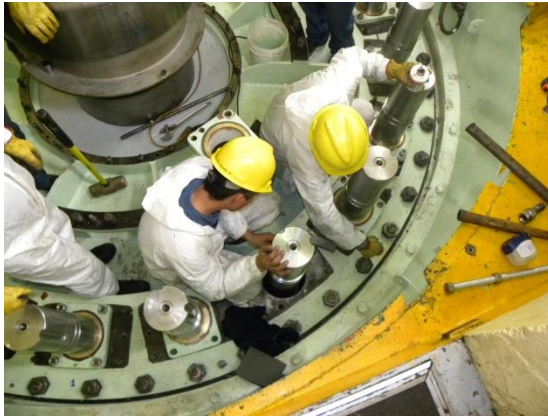
Figuras 5.29. y 5.30. Armado componentes del distribuidor.
