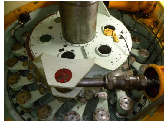
Figuras 5.31. y 5.32. Armado sello y chumacera turbina.
