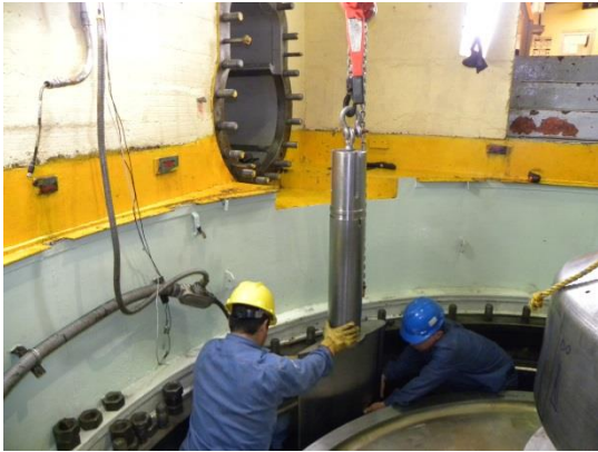
Figuras 5.25. y 5.26. Montaje álamos de distribuidor turbina.
