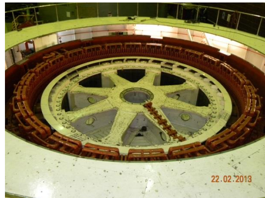
Figuras 5.45. y 5.46. Rotor de generador eléctrico montado.
