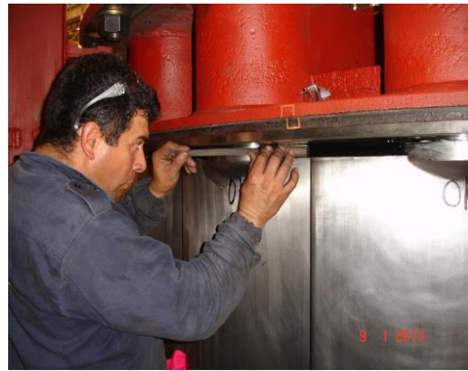
Figuras 5.8. y 5.9. Proceso de ajuste de álabes
