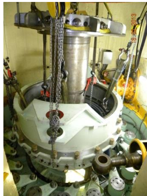
Figuras 5.31. y 5.32. Armado sello y chumacera turbina.
