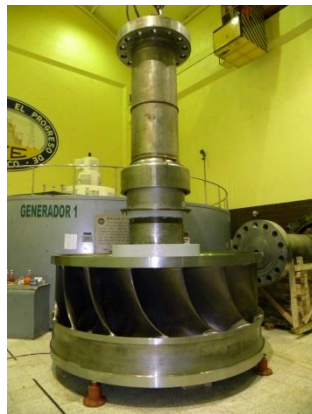
Figuras 5.21. y 5.22. Montaje rodete y eje de turbina.
