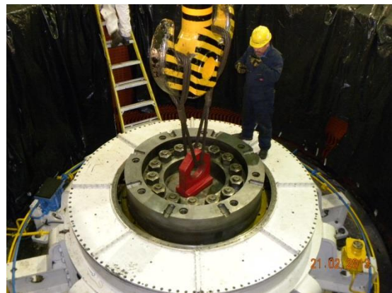
Figuras 5.35. y 5.36. Montaje eje de generador.
