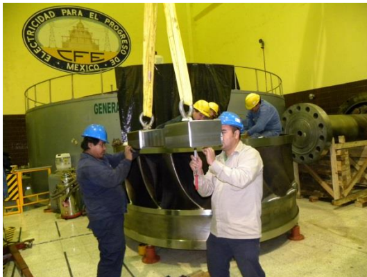
Figuras 5.19. y 5.20. Acoplamiento rodete con eje de turbina.
