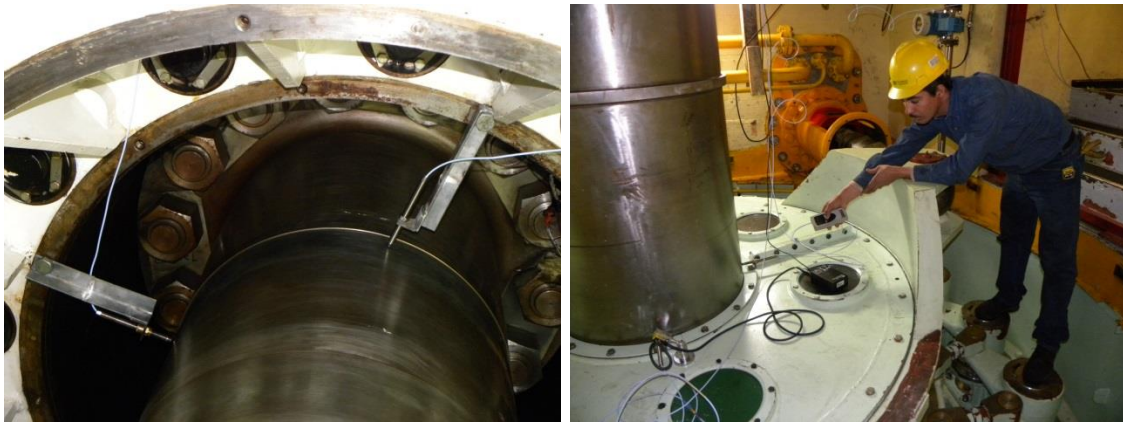
Figuras 6.2. y 6.3. Colocación de instrumentación en ejes de generador y turbina para pruebas de comportamiento dinámico.
