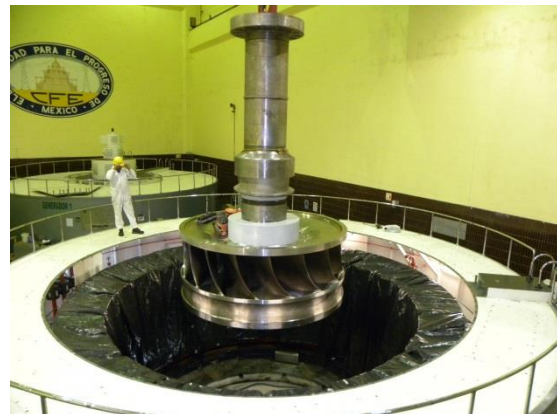
Figuras 5.21. y 5.22. Montaje rodete y eje de turbina.
