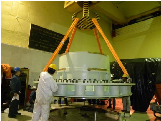
Figuras 5.27. y 5.28. Montaje tapa de turbina.
