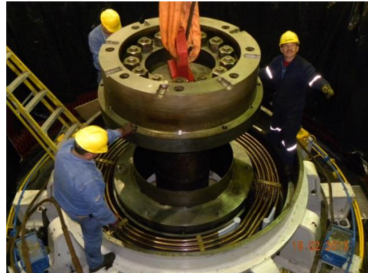
Figuras 5.35. y 5.36. Montaje eje de generador.
