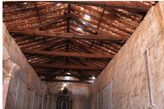
Figura. 93.- Armadura de madera con teja rojo recocido.
