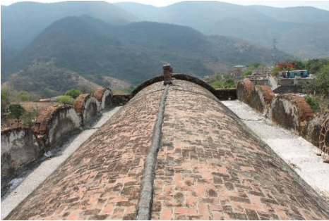
Figura. 91- bóveda de cañón corrido de la capilla de San francisco de Asís
