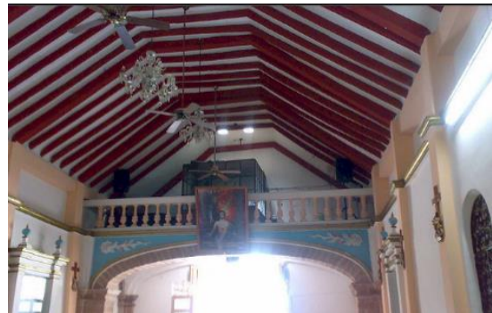
Figura: 44 Vista del interior, hacia el coro alto. Foto, J.O.B.G. 2017
