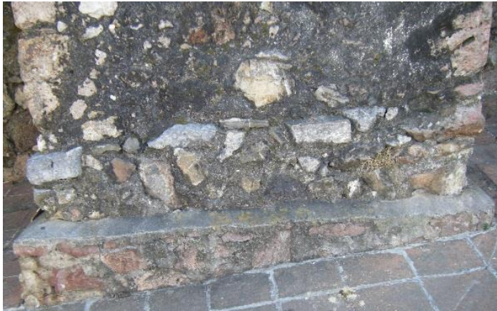
Figura: 98.- zapatas aisladas de la capilla de San Nicolás Tolentino. Autor JOBG, Año. 2017
