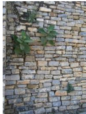
Imagen: 104.- muros de mampostería y sillares de piedras de refuerzo en muros de la capillas de san francisco de asís. Autor JOBG, Año. 2017
