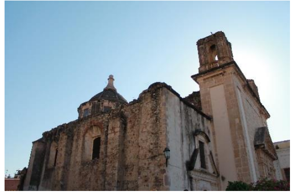
Figura: 54 fachada lateral, orientación Poniente. Foto, J.O.B.G. 2017
