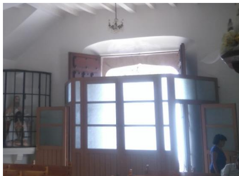
Figura: 116.-Capialzados en puertas en la capilla de la San Tisima Trinidad. Autor JOBG, Año 2017
