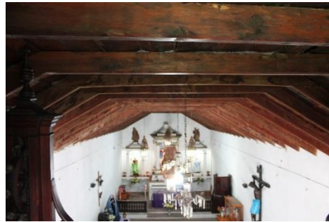
Figura. 92.- armadura de madera y en su interior una cubierta de artesanado de madera.
