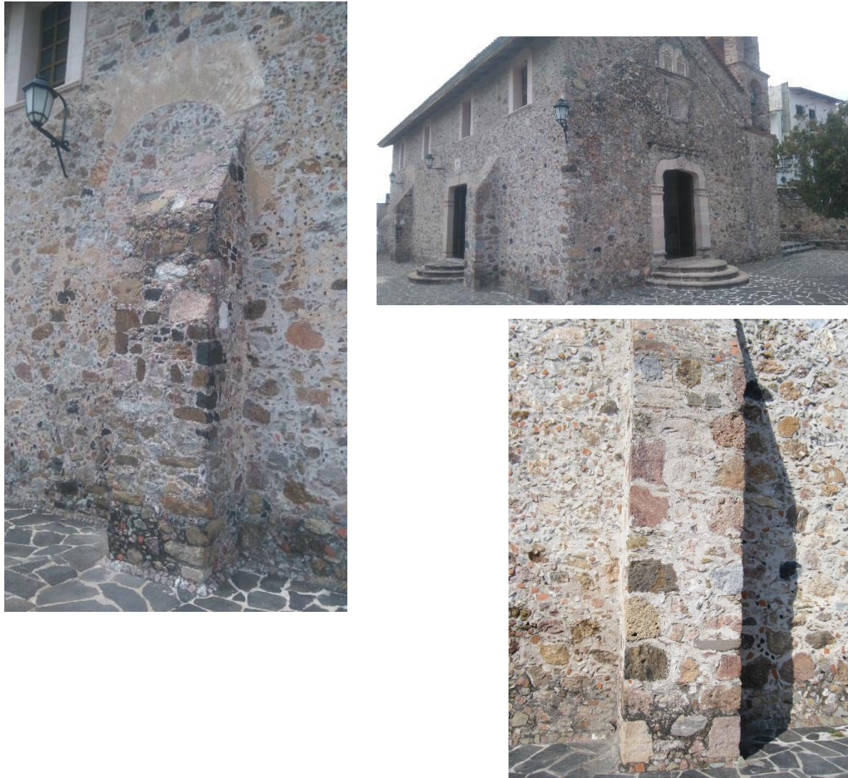
Figura: 108.- Contrafuertes de la capilla de Santísima Trinidad en Taxco el nuevo. Autor JOBG, Año. 2017
