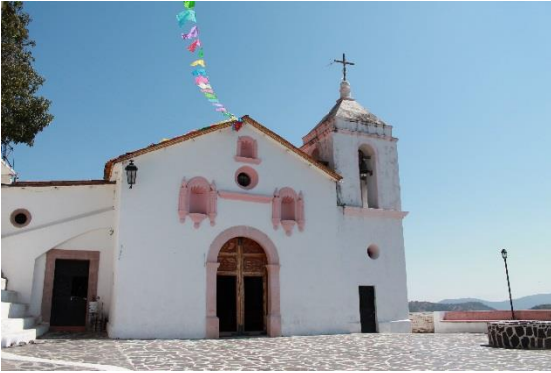
Figura: 37.- Fachada principal de la capilla orientación sur. Foto, J.O.B.G. 2017
