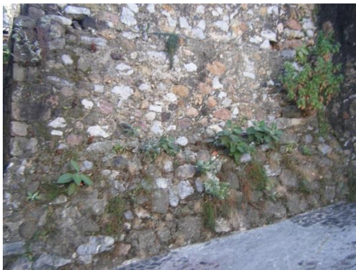
Figura: 12.- Capilla de San Nicolás Tolentino, Erosión en muros de mampostería y plantas Parasitas. Fotografía tomada por J. Omar Bahena Gutiérrez, 2017.
