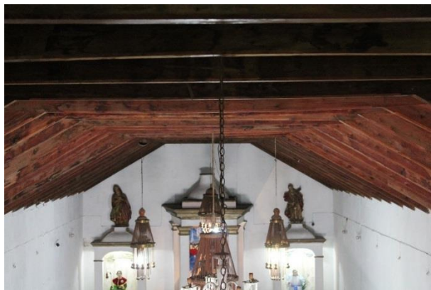
Imagen: 118.-Amradura de madera y en el interior un plafón de artesonado de madera en la capilla de San Nicolas Tolentono en Taxco el viejo. Autor JOBG, Año 2'17.
