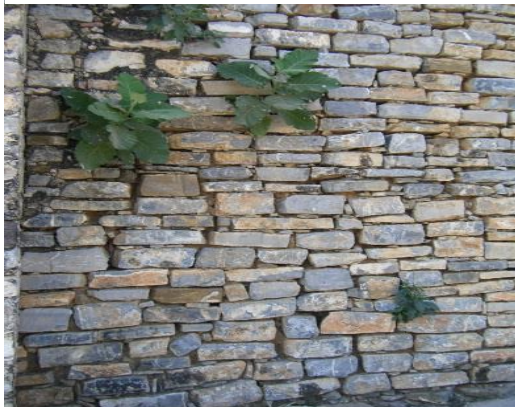
Figura: 12.- Capilla de San Nicolás Tolentino, Erosión en muros de mampostería y plantas Parasitas. Fotografía tomada por J. Omar Bahena Gutiérrez, 2017.
