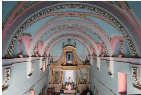
Figura. 91- bóveda de cañón corrido de la capilla de San francisco de Asís
