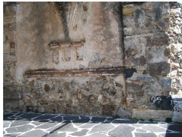
Imagen: 102.- Muro de mampostería aparejada de la capilla de la San Miguel Arcángel Fotografía y dibujo Autor JOBG, Año. 2017
