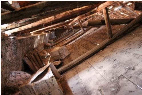
Figura. 92.- armadura de madera y en su interior una cubierta de artesanado de madera.
