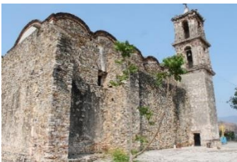
Figura. 89.- contrafuertes de la capilla De sanfrancisco de asís.
