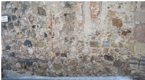
Figura: 96 cimientos sobre sale del muro. En la capilla de San Nicolás Tolentino. Autor JOBG, Año. 2017
