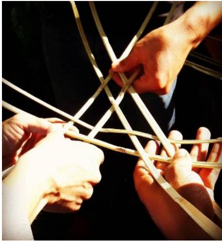
Foto 1. Amarre de carrizo Fuente: propia
