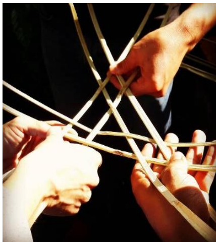
Foto 1. Amarre de carrizo Fuente: propia
