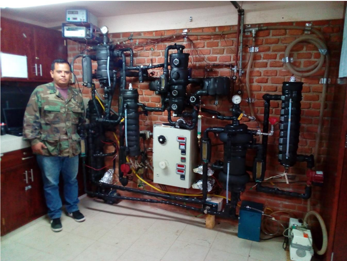
Ilustración 43 Fotografía del TCA en su estado actual
