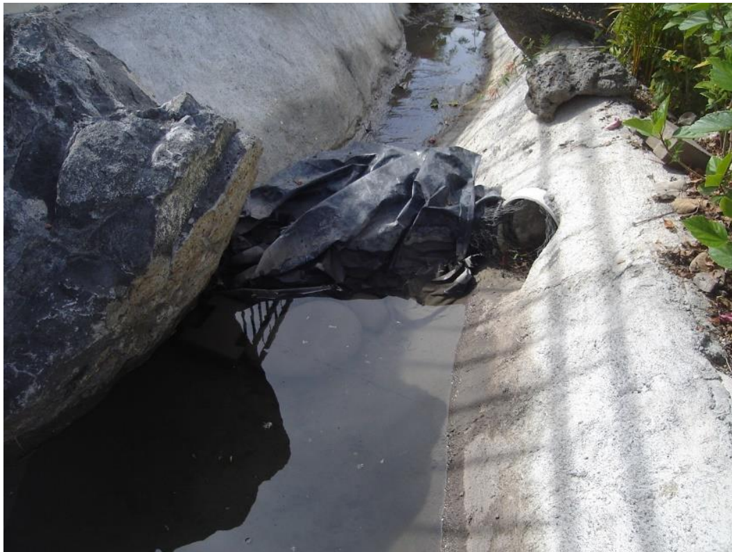
Figura 5. Bloqueo de canales de riego dentro de La Provincia
