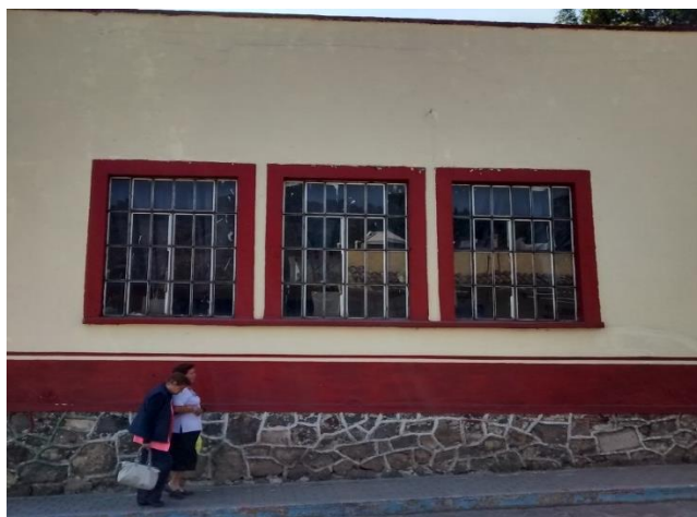
A) Antes de la intervención.
