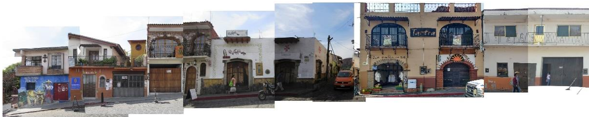
Figura 4. Fachadas modificadas en el cuadro mágico Fuente: Meztli Esquivel, tomada en marzo de 2016
