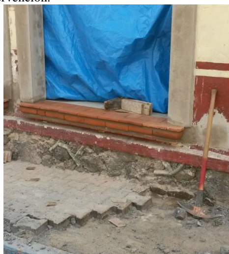
C) Modificación de la fachada para la instalación de balcones
