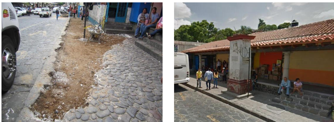
A B Figura36. Cambio de empedrado Av. 5 de mayo, frente al auditorio de Tepoztlán, Morelos Fuente: A) Mezтли Esquivel, junio de 2016, B) Fotografía obtenida en Google earth octubre de 2018
