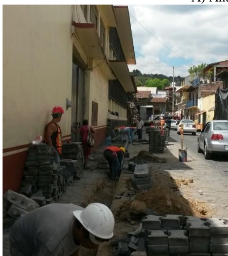
B) Foto tomada durante los trabajos de modificación de las ventanas
