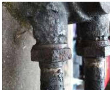
**Figura 2.** Conexión de tuberías, que muestra corrosión galvanizada.
