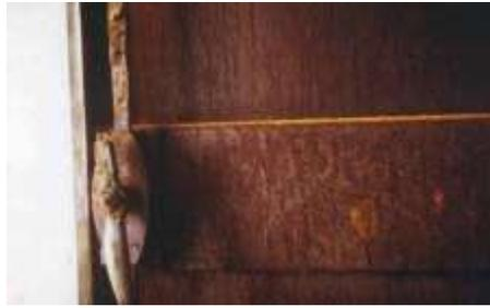
**Figura 10.** Puerta que presenta corrosión generalizada.
