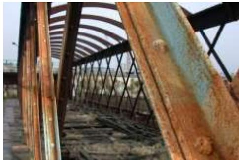
**Figura 7.** Puente cuya estructura metálica se encuentra muy deteriorada
