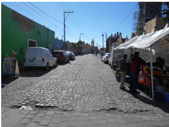
Foto 46. Cambio de pavimentación 105
