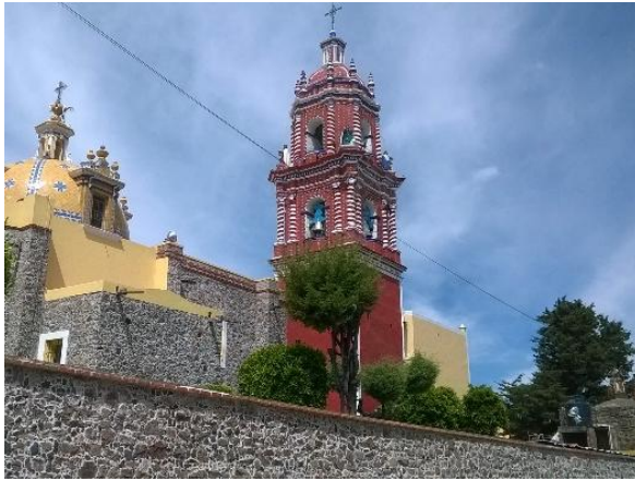
Foto 3. Torre de campanario 29
