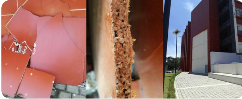
Figura 2.12. Paneles de edificios hechos de concreto reforzado con fibras de vidrio.
