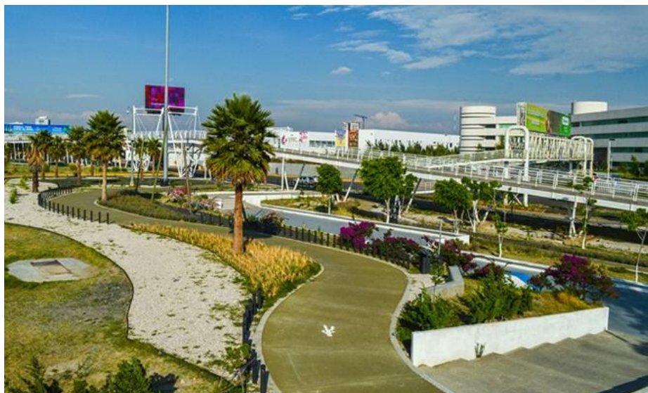
Fig. 28. Andador en la vía Atlixcáyotl. Puebla. Imagen: arquitecturapanamericana.com
