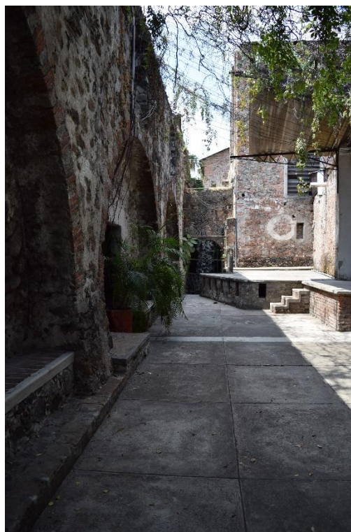
Imagen 6, Fondo personal en Alejandro Ramirez Ortiz, "fotografía donde se muestra parte del vestigio del acueducto de la Ex Hacienda de Temixco", Temixco, Morelos, 09 de abril de 2025.
