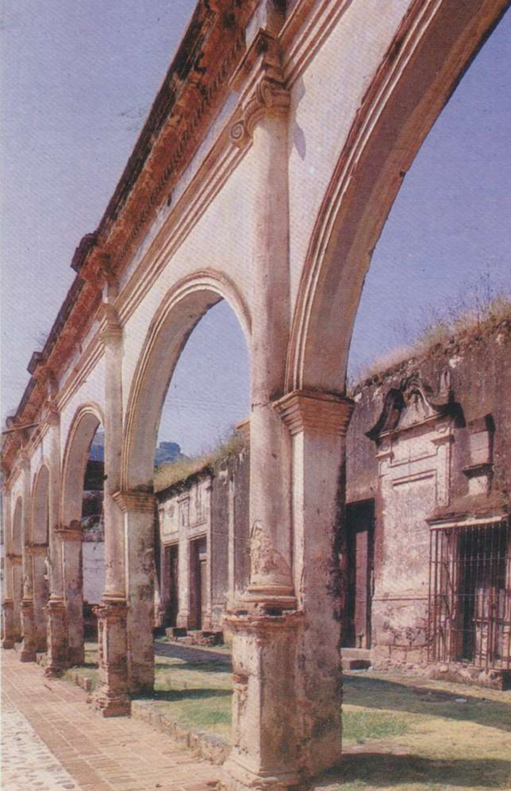
◀ Imagen 45. La Cerería abandonada en la década de los años setenta. AHEC.
