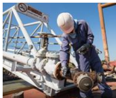
Figura 4. Corrosión que Pone en Peligro al Trabajador 11
