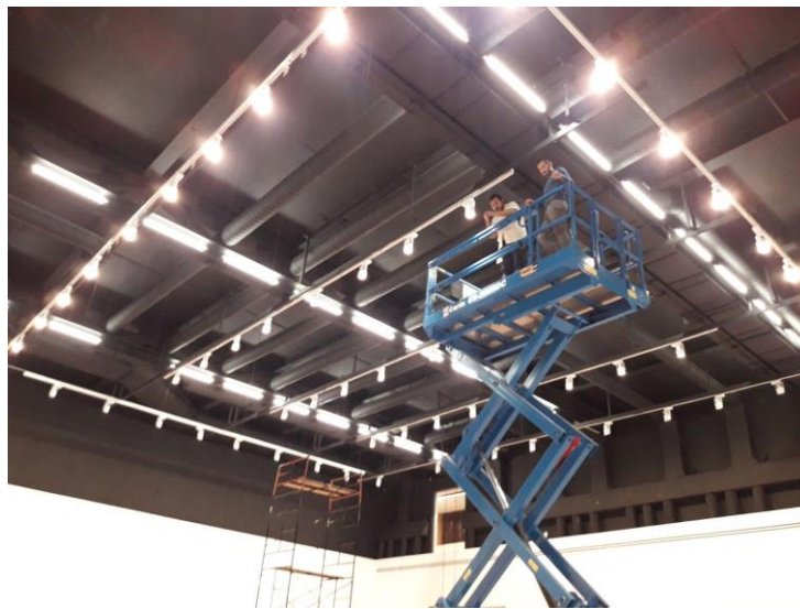
Instalación de la obra Vilos
