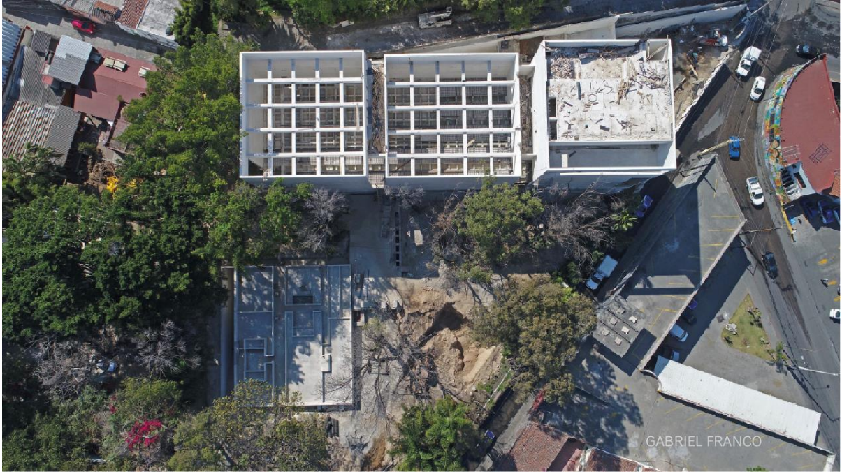
Fotografía del área de construcción del MMAC. Autor: Gabriel Franco
