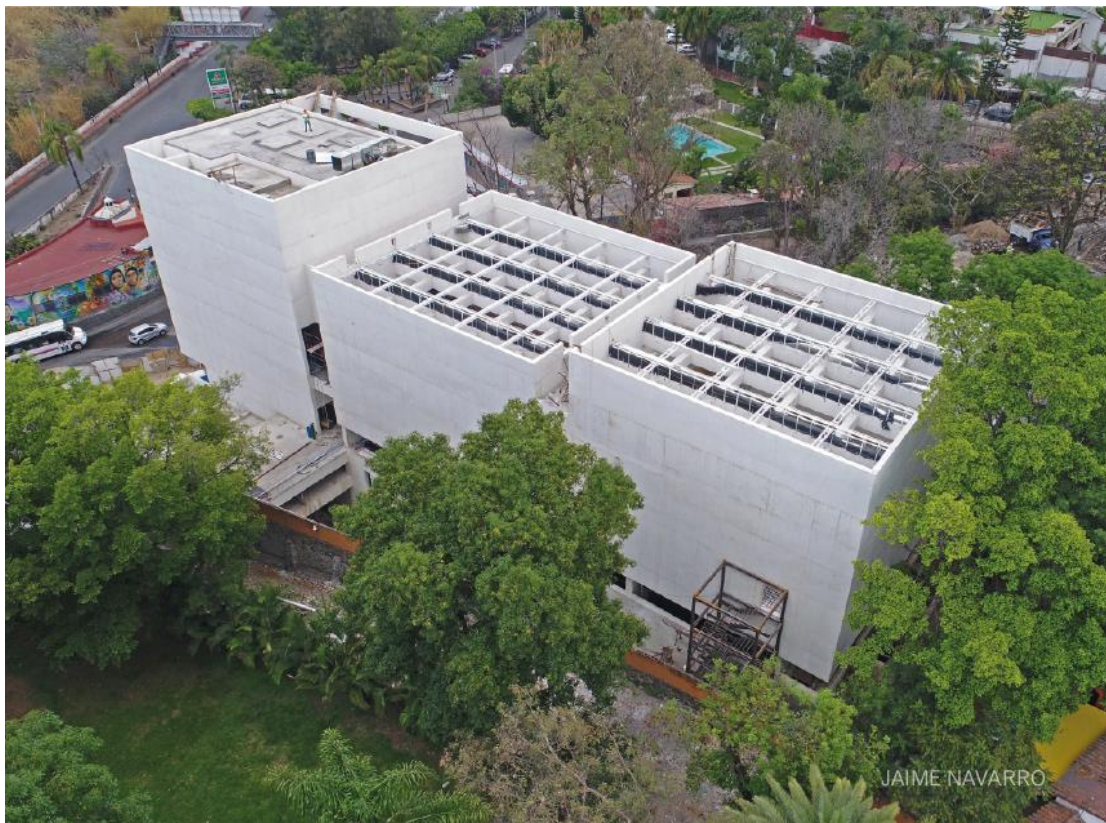
Fotografía de edificio principal en construcción Autor: Jaime Navarro
