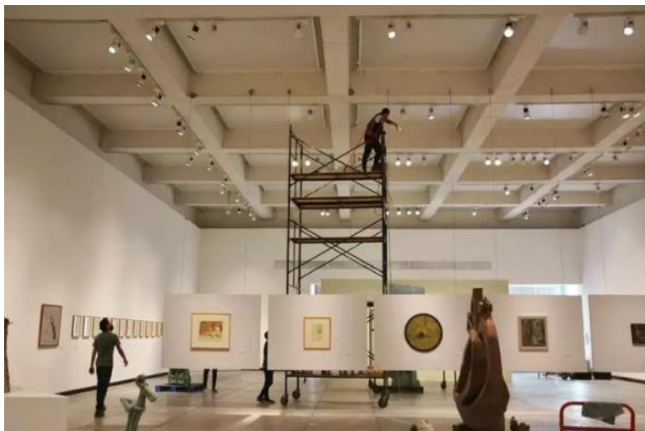
Trabajos de iluminación en sala
