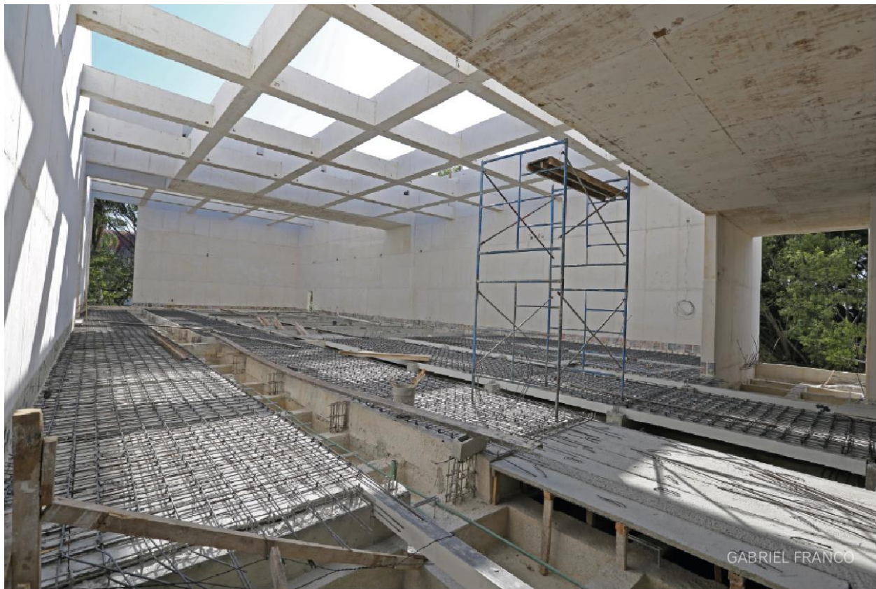
Fotografía de la Galería Central del MMAC en construcción. Autor: Gabriel Franco
