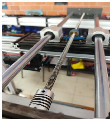
Figura 77: Primer Problema detectado en la estructura del Módulo de Monitoreo. Fuente: Elaboración Propia 2024
