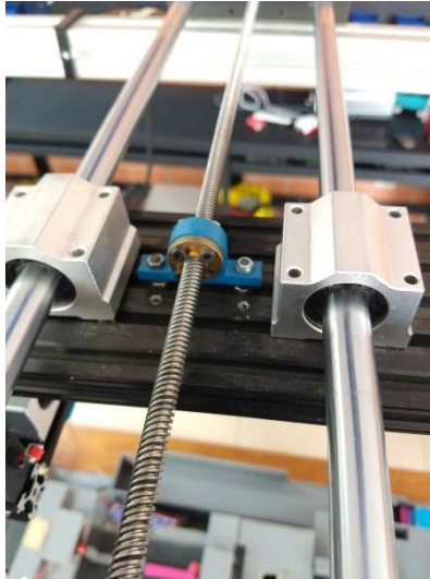
Figura 78: Segundo Problema detectado en la estructura del Módulo de Monitoreo. Fuente: Elaboración Propia 2024
