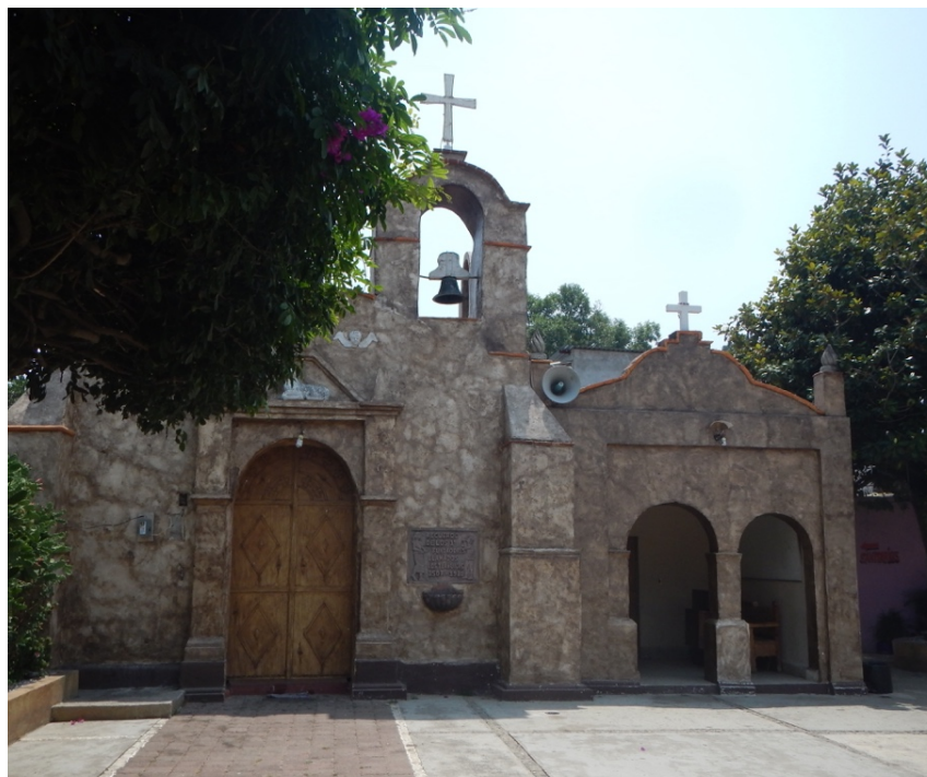
Imagen 5. Fachada poniente de la capilla de la Candelaria de Ocotepéc Morelos. Fotografía tomada por Efrén Romero Benítez, abril del 2019.
