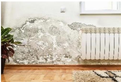
**Figura 8.** Humedad en la pared.
