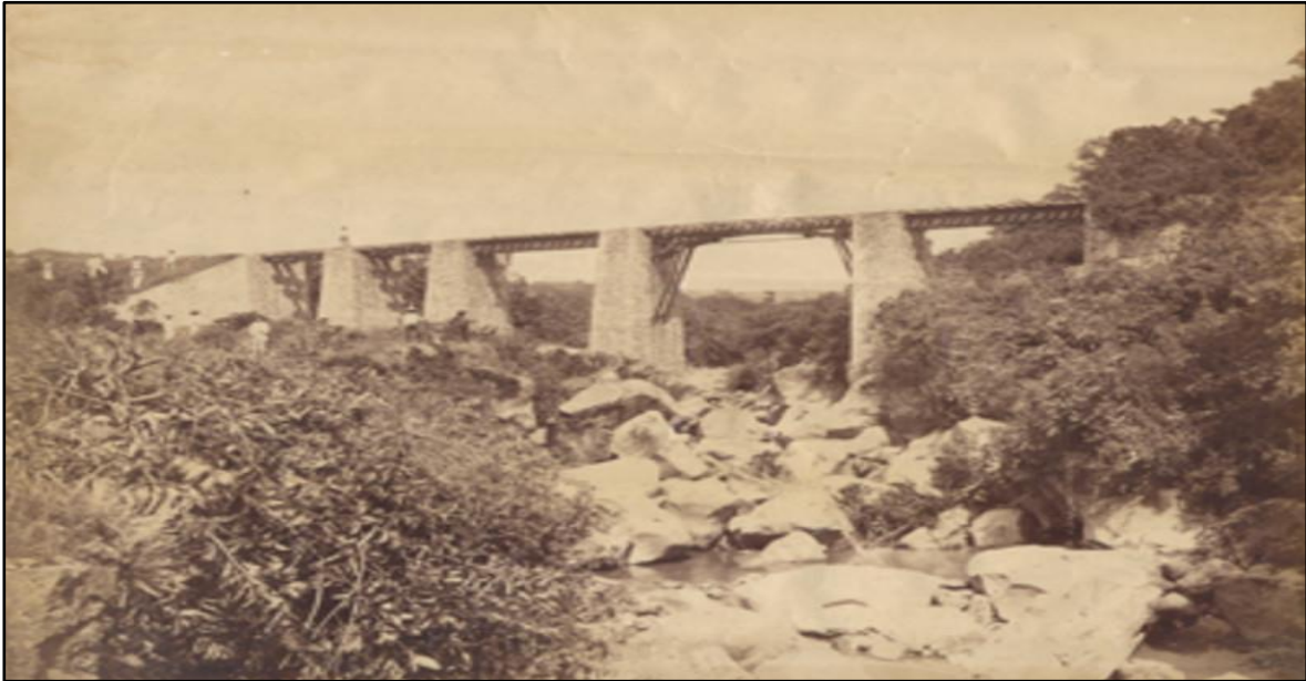
Figura 26. Puente de Nepantla
