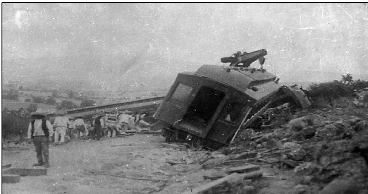
Figura 22. Voladura de tren en Cajones
