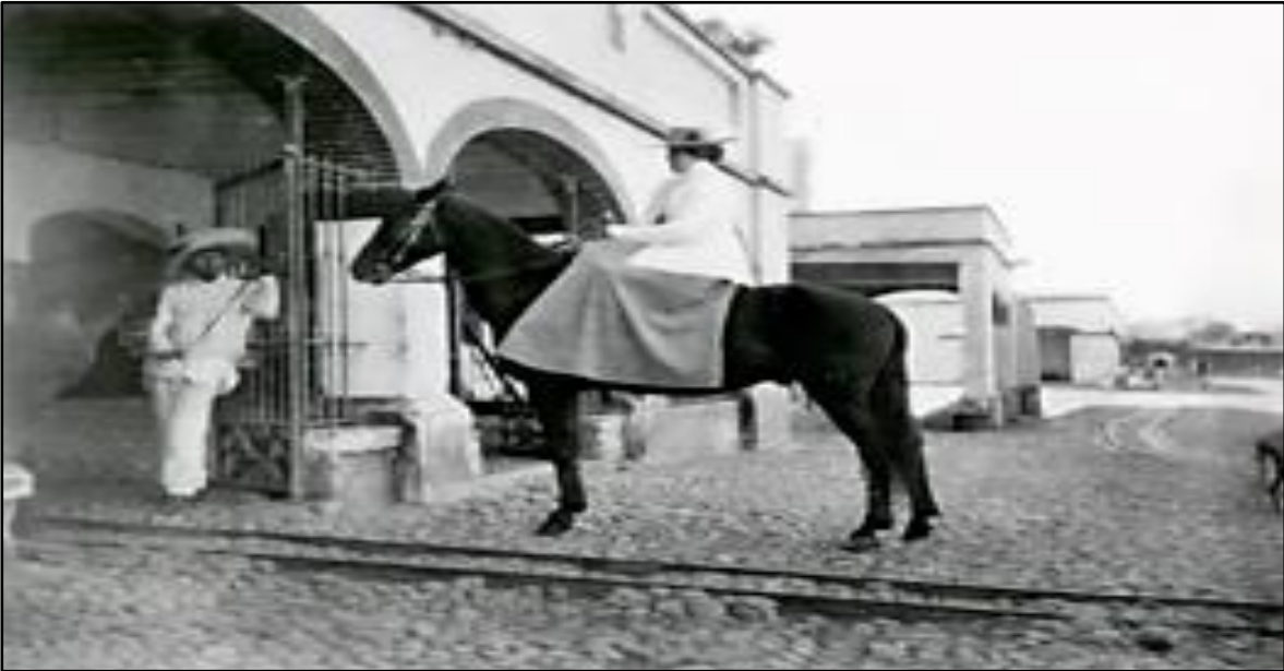
Figura 13. Vía interna Decauville de la hacienda de Tenango
