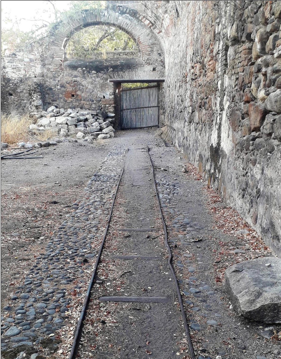
Figura 14. Restos materiales de la vía Decauville de Tenango
