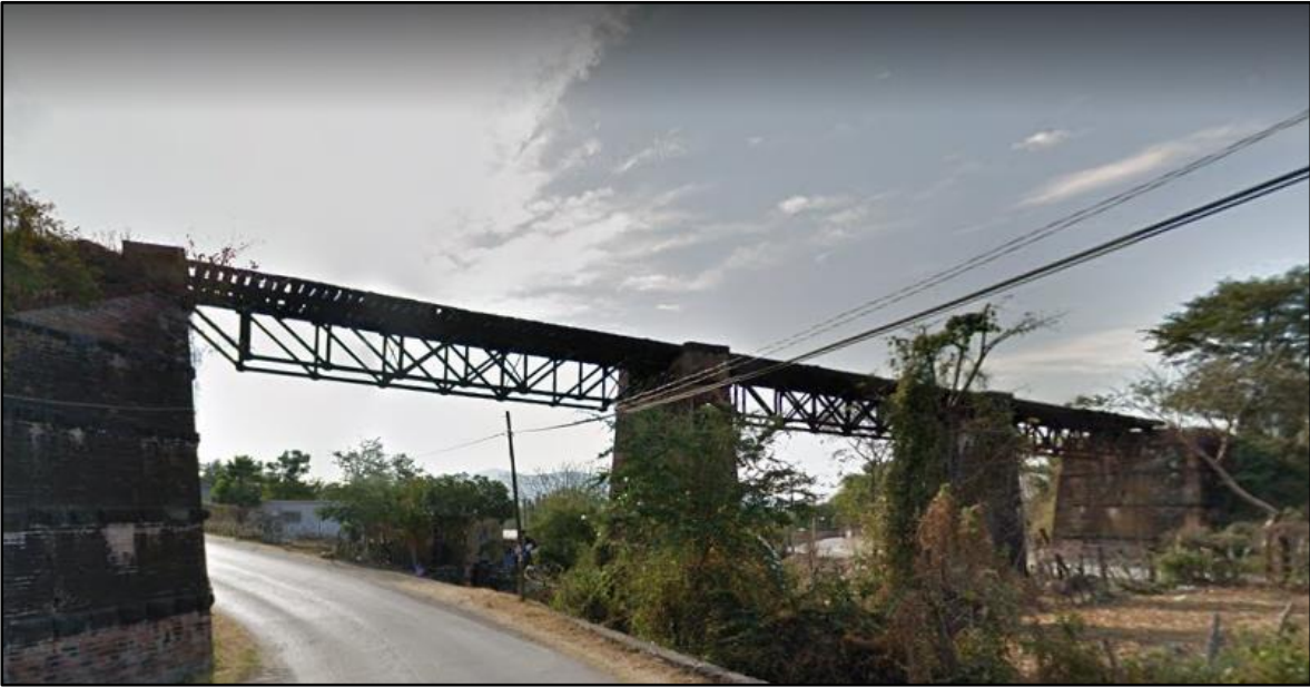
Figura 27. Puente de Barranca Honda
