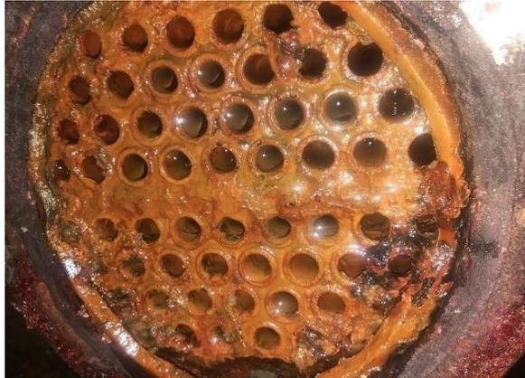
Figura 2.23 Incrustación por corrosión
