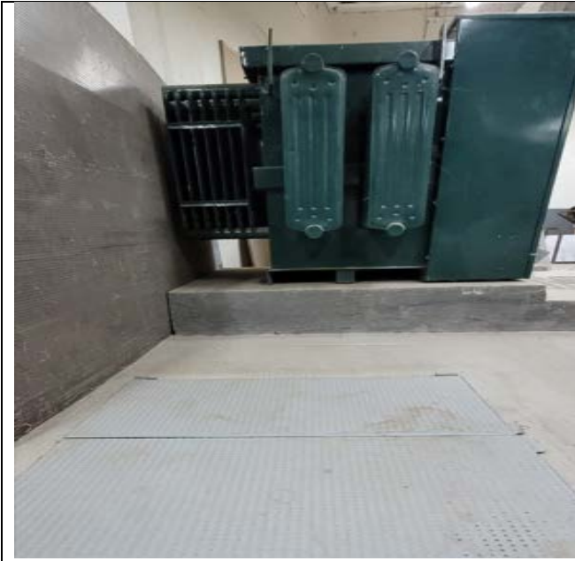
Cárcamo del transformador.
