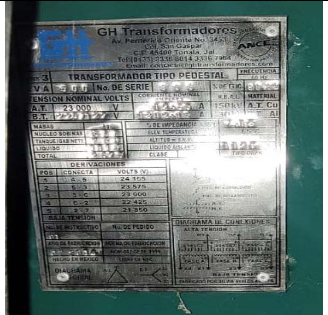
Placa de datos del Transformador.
