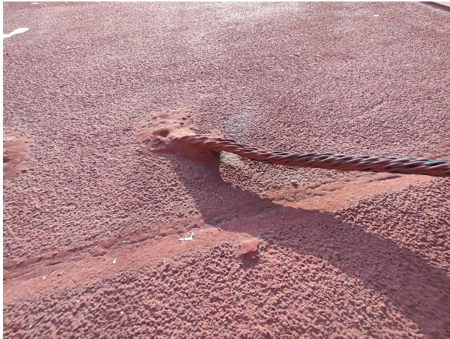
Punto de inicio de bajada del cable de cobre desnudo
