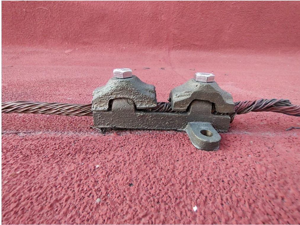
Conexión mecánica del cable proveniente de los pararrayos
