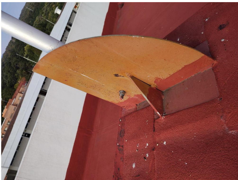
Base se pararrayos vista frontal
