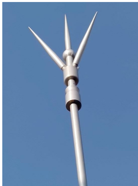
Punta captadora tipo Franklin
