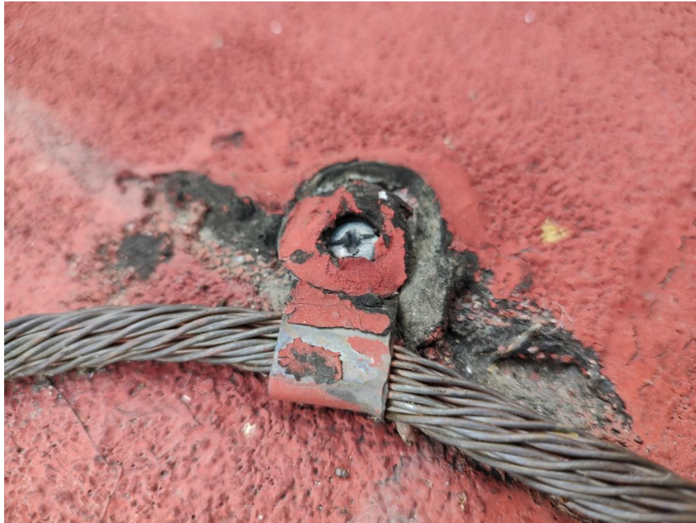
Unión del cable a la superficie del techo
